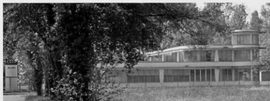
Felix Wankel Institut in Lindau. Das Gebäude steht leer
